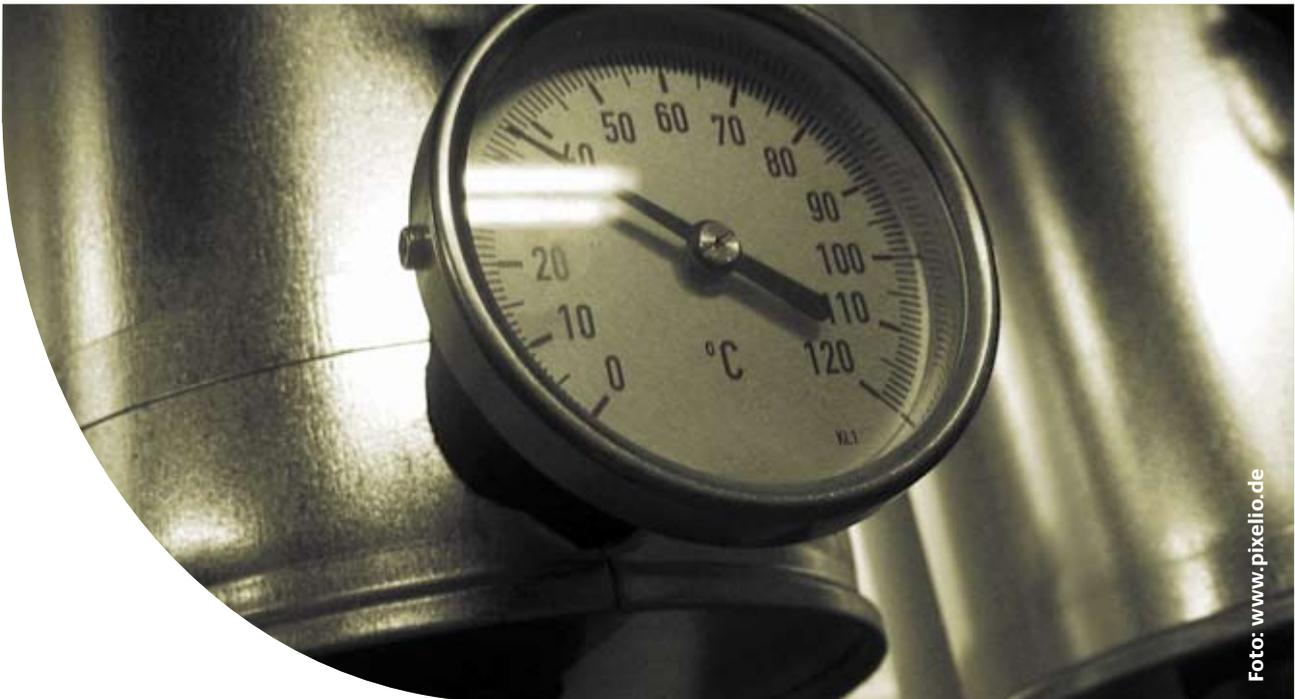
zu halten. Um zu erkennen, wie lang die Überhitzungsstrecke ist, kann der Grad der Überhitzung als Temperaturdifferenz zwischen Zwei-Phasen-Gebiet und Verdampferausgang gemessen werden.
